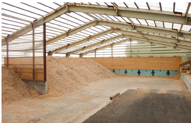
写真1 旧鵜苦小学校プールを改修したチップ乾燥施設
