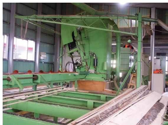
写真3 傾斜型本機と耳付きの広葉樹製材
