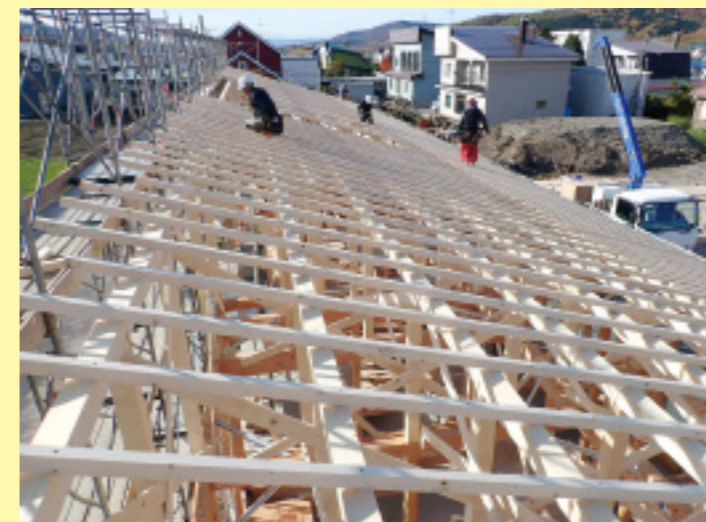
■認証材使用例:下川町営住宅
