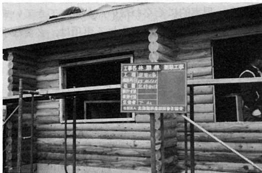
写真6 建具枠取り付け（休憩棟）
