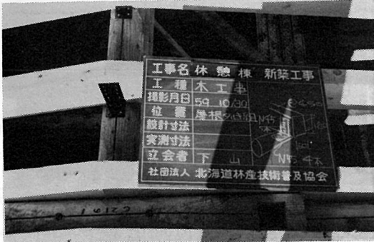
写真4 小屋組み（休憩棟）
