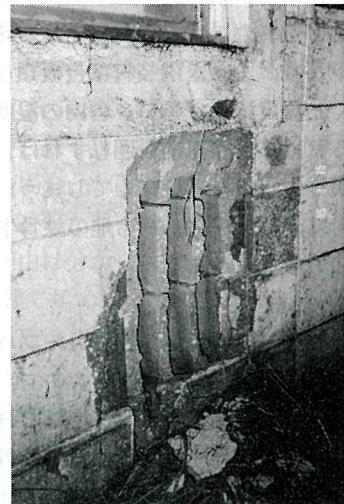
火山灰ブロックは凍害により破壊する(10年目)。
