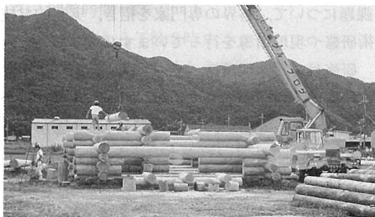
建設中のログハウス
