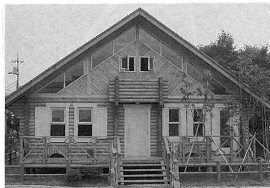
カラマツのログハウス 北海校倉ハウス (東京木材サービスセンター展示場,昭和63年竣工)
