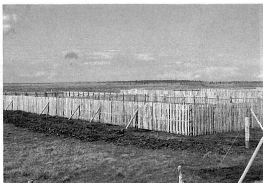
海岸線緑化保全に使ったカラマツ防風工 垣高1.5m(根室市納沙布)
