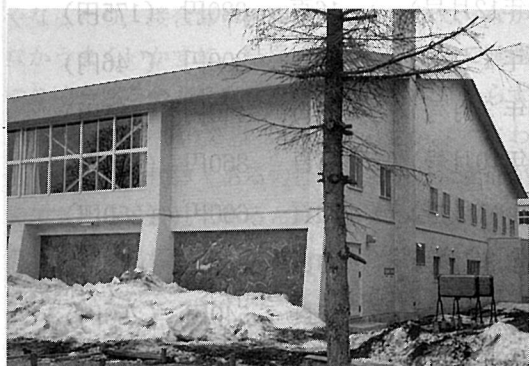
カラマツセメントボードを使った屋内体育館 (滝川市立西高等学校, 昭和63年12月完成)
