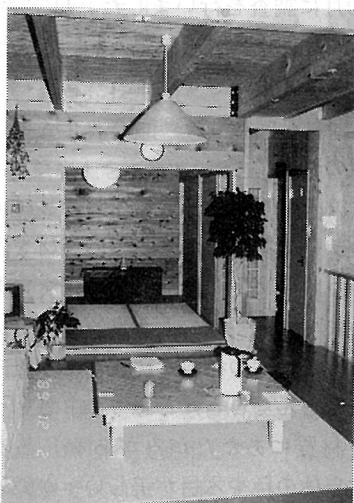
写真3 節有り材の使用例 (木質内装材)
