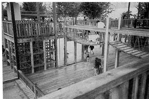
写真8 板張りの橋脚部(名古屋市)
