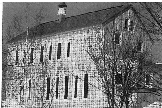
写真13 トドマツ張りの外壁
