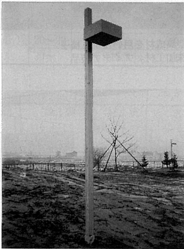
木製ポール（照明灯） 角材の木表を接着（中心には径50mmの鋼管入り） の集成材。防腐処理，保護着色塗料塗布
