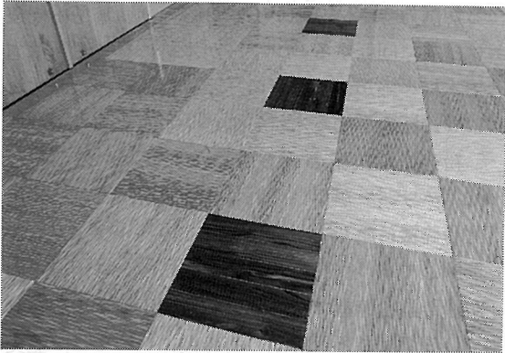
写真9 カラマツ蒸煮処理製品の施工例 (帯広営林支局)
