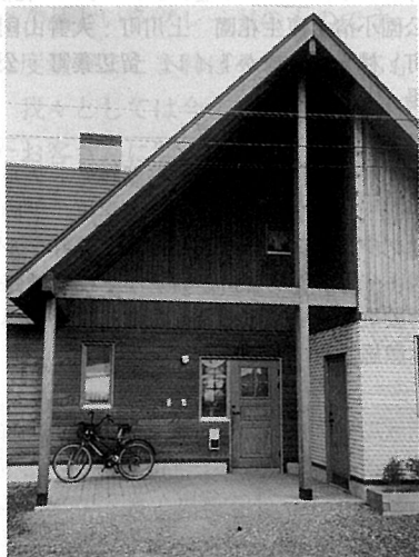
写真4 玄関ホールの壁板
