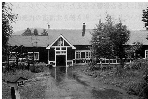
写真14 旧東川第五小学校
