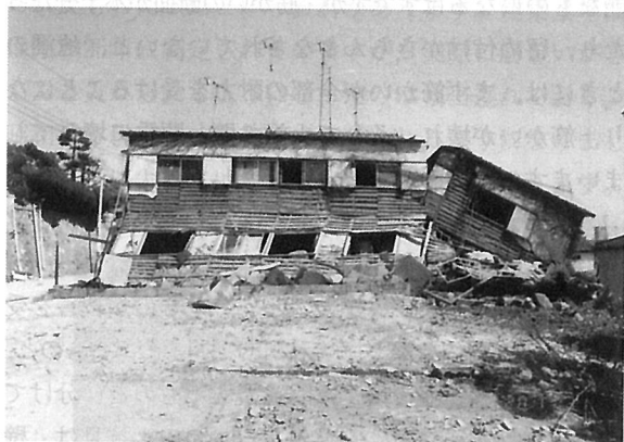
写真4 文化住宅の被害
