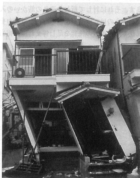
写真6 正面が全面開口の住宅
