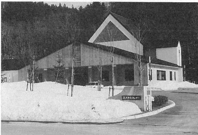
置戸町 置戸浄化センター
