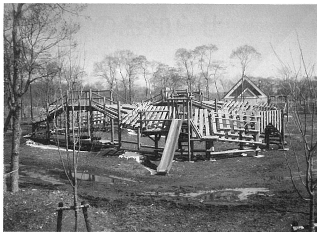
写真1 綿多峰公園(平成6年設置)
