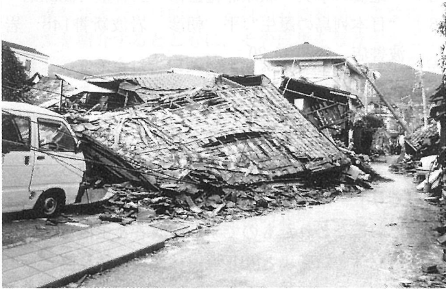
被害例一9 住宅崩壊 (芦屋市)
