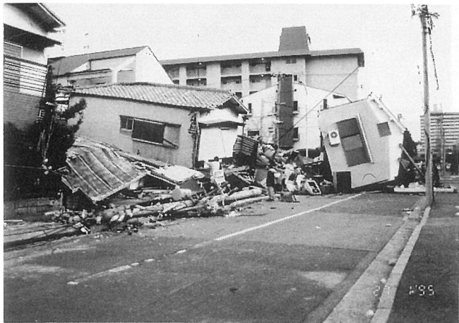
被害例一10 住宅、一階崩壊 (芦屋市)
