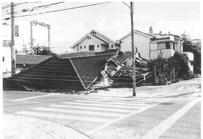
被害例一八 住宅崩壊〈芦屋市〉
