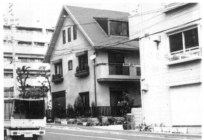
被害の見あたらない新しい住宅 (神戸市東灘区)
