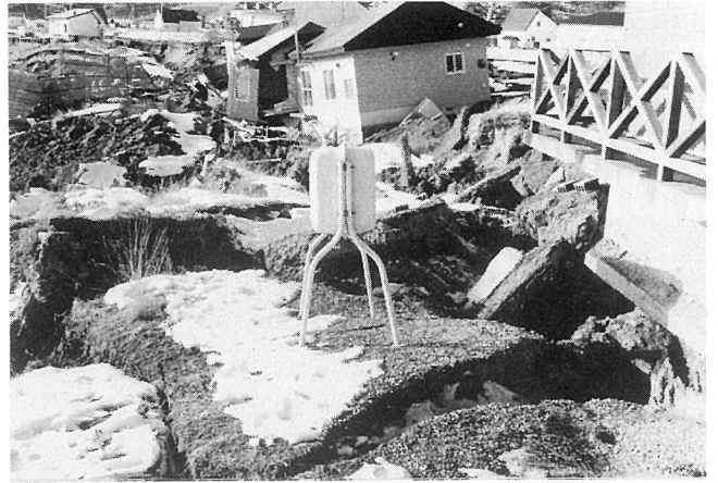
被害例—4 造成地での地崩れ〈標茶町〉
