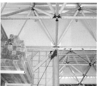
屋内のストックヤードの屋根にはスギ小径木のトラスが使われています。
