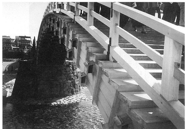
写真8 橋板の張出し, 葺板, 梁類の木口覆い
