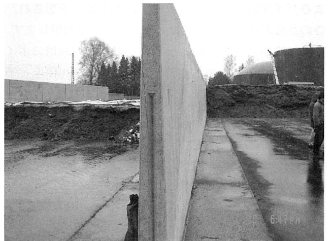
写真 10 原料貯蔵場(2面で1年分、上からシートがかけられサイレージにされている)
