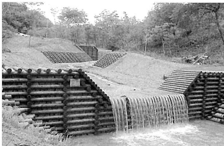
第15図 針葉樹円柱加工丸太使用谷止め工（梶井木材工業提供）
