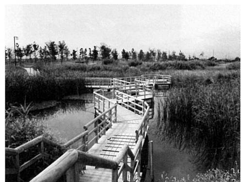
第12図 スギ材を用いた浮き桟橋構造の八橋（群馬県館林）
