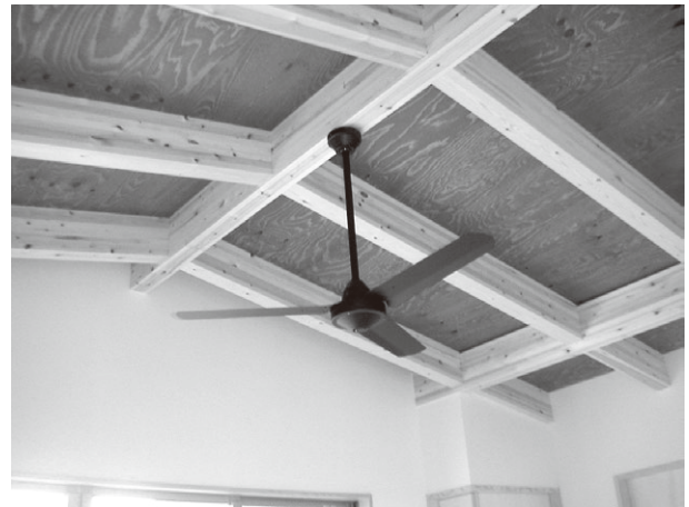
図16. ネダノンによる屋根構造
