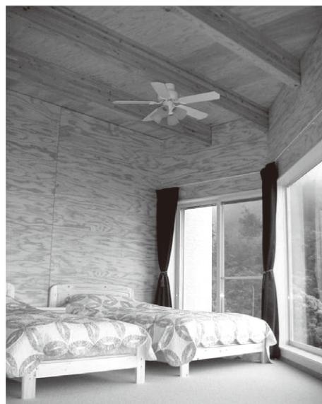
図14. 無塗装のスギ合板の内装
