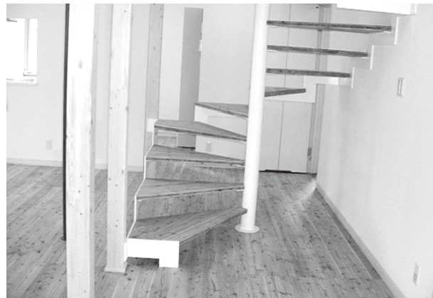
階段踏み板への使用例
