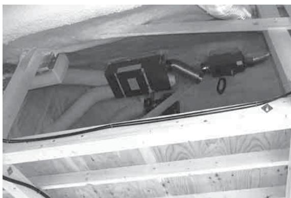
図5 屋根裏の換気装置
