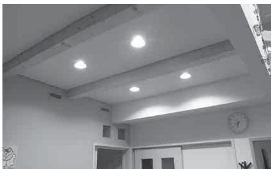
写真5 リビングのLEDダウンライトとトドマツ集成梁
