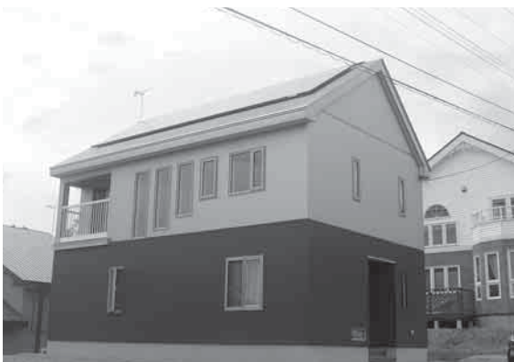
写真2 太陽光パネルの搭載状況
