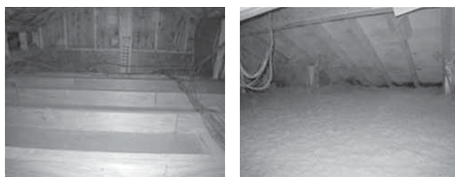
ウッドファイバーBL 施工前・施工後
