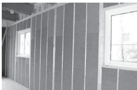
ウッドファイバーLD 施工後
