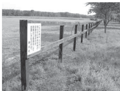
写真-1 カラマツ材防腐加工牧柵
