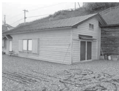
写真-2 スギ材利用のコンブ小屋
