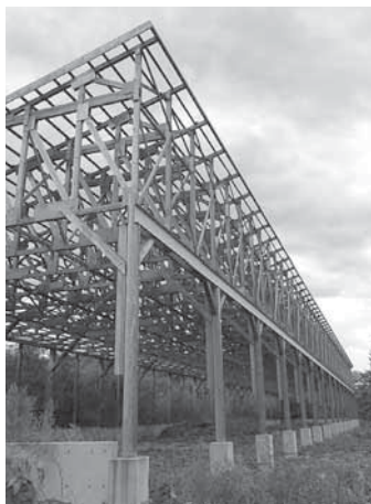
木造堆肥舎 遠軽町
