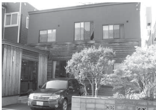
道南スギを用いた外観
