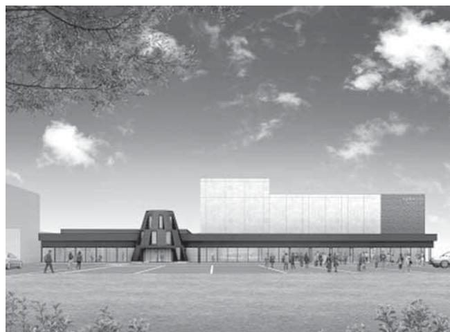
建物は公民館ゾーンとホールゾーンの2つに分かれており、公民館部分は木造平屋建て延べ床面積451m<sup>2</sup>、ホール部分はRC構造一部2階建て延べ床面積983m<sup>2</sup>で、総面積1,434m<sup>2</sup>となっています。木造部分には町産材のカラマツ集成材、トドマツ製材を構造材に使用、またフローリングや壁には町産材広葉樹を使用し、総木材使用量は約100m<sup>3</sup>の計画です。また、RC部分についても内装材には町産材広葉樹のカバ類、シナ、ニレ等を約60m<sup>3</sup>使用する予定になっています。
