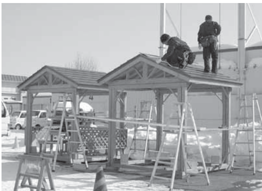
(試作1号設置作業及び屋根工事)
