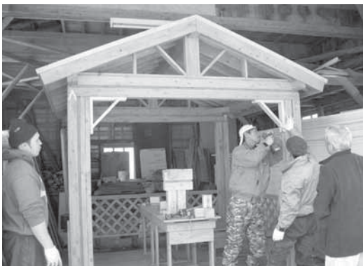
(開高建設作業所)
