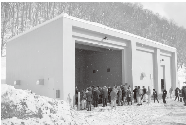
（ボイラー建て屋兼チップ保管庫）
