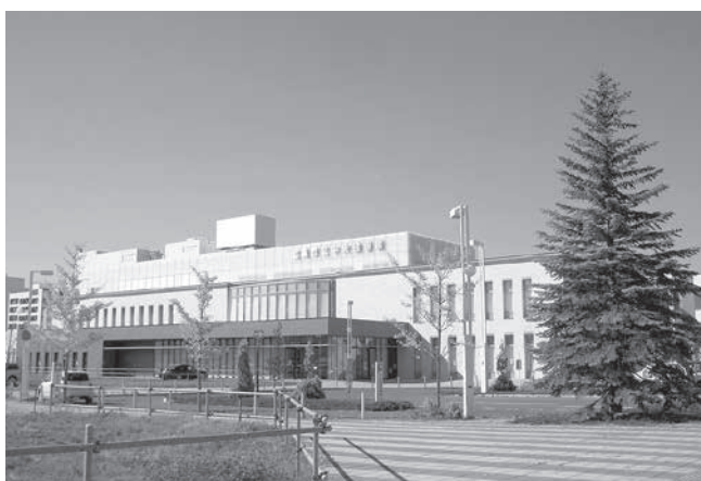
(新しく生まれ変わった北見市立中央図書館)
