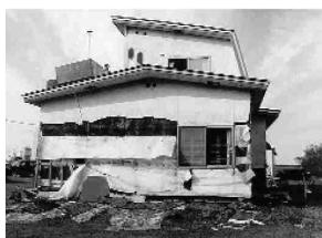
ダンマット工法による木材腐朽の例
