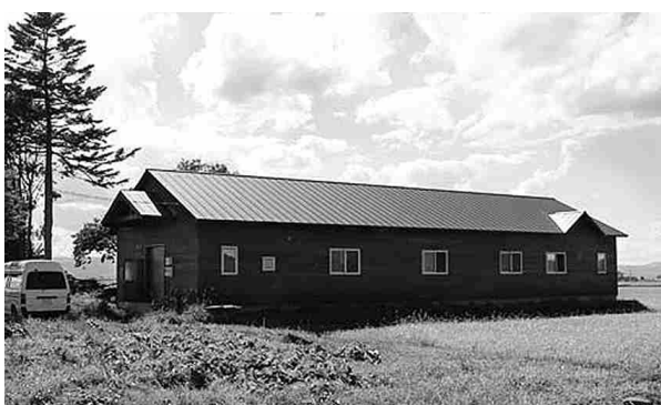
東川町の田んぼに囲まれた工場
