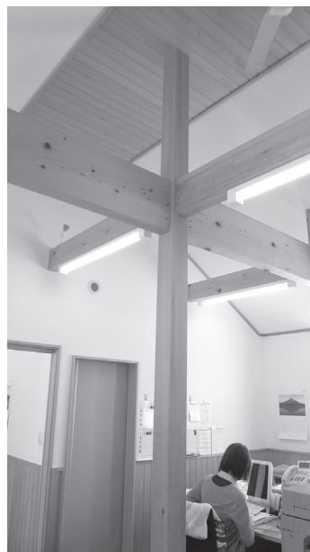
十勝の無垢エゾマツ構造材を用いた社屋、柱は天然林アカエゾマツ材200~300年生、梁は天然林クロエゾマツ材
