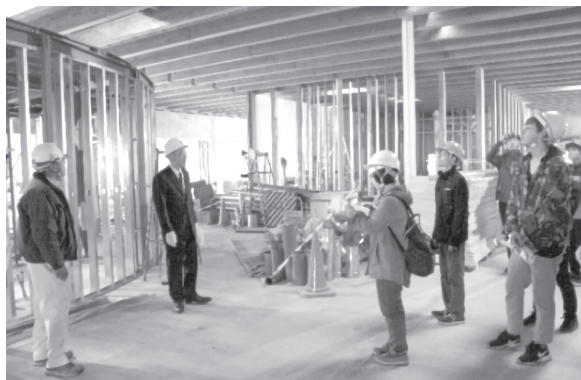
写真4 「留辺薬小学校」の施工中の様子を見学
