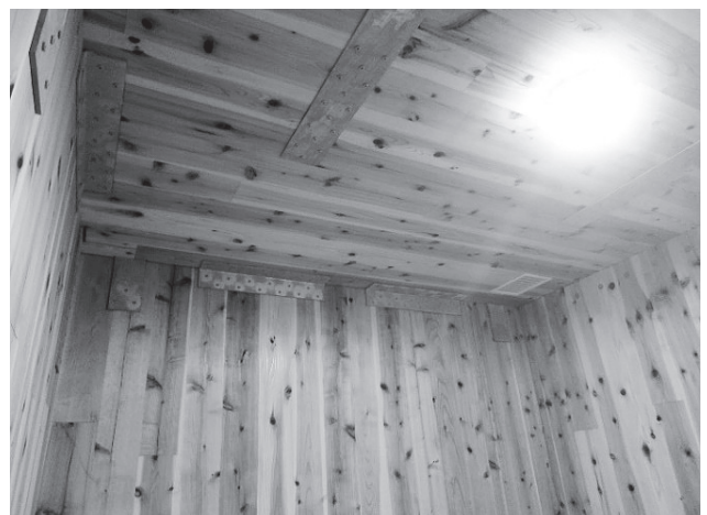
写真5 見学した集会所のCLT接合部
