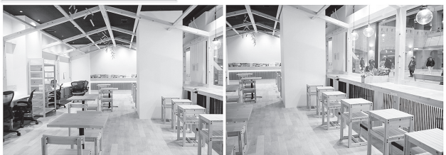
小屋組の柱と梁は東濃ヒノキ 床板はシラカバの無垢材
