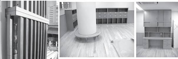
ヒノキ挽板複合フローリング (t 3mmヒノキ挽板+ t 12mm針葉樹合板)
