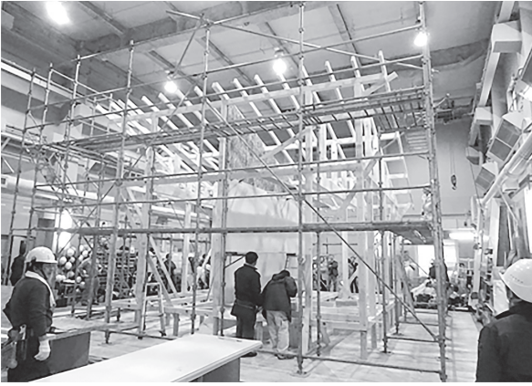
木造応急仮設住宅の建方実技の研修
