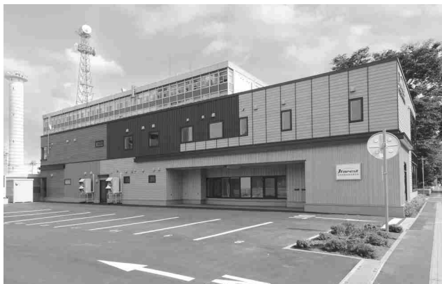
写真1 事務所全景（北側から）
