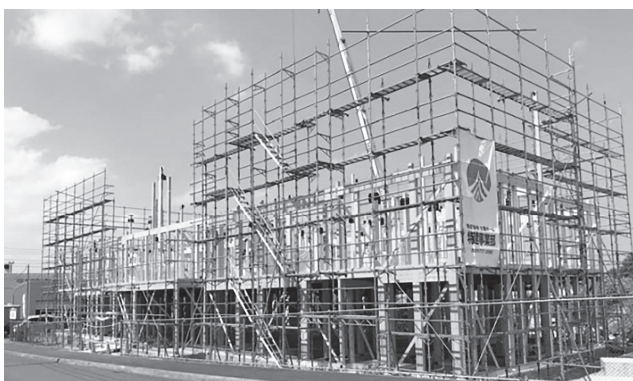
図3 建築現場（8月上旬）（(株)土屋ホーム提供）
