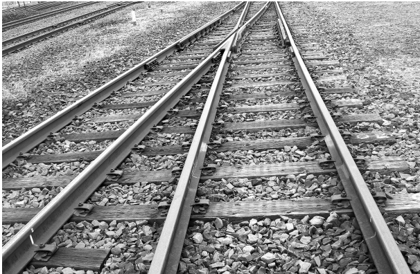
写真1 長さの異なる枕木が使用されるレールの分岐
