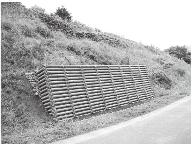
写真6 土留工 (2012年・様子町)
