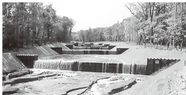
写真3 床固工 (2013年・苫小牧市)
