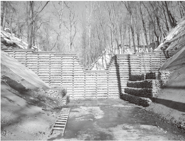
写真4 床固工 (2015年・むかわ町)
