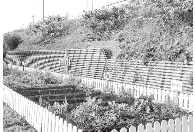
写真7 土留工 (2012年, 2015年・えりも町)
