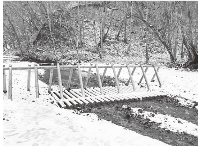
写真8 簡易流木補足工 (2019年・むかわ町)
