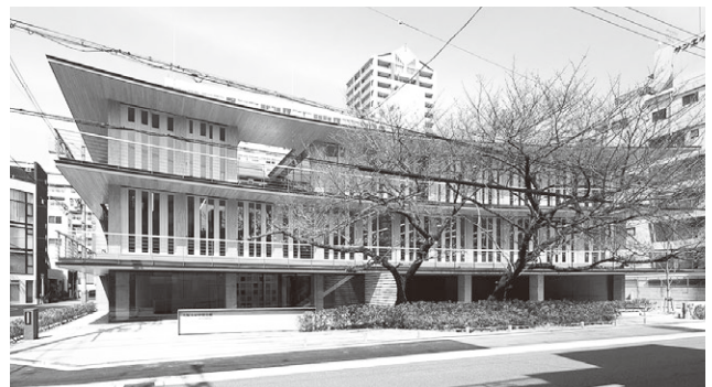
写真1 大阪木材仲買会館 地上3階、延床面積1,032m 2
