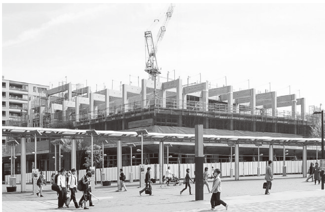
写真2 サウスウッド 地上4階・地下1階, 延床面積10,874m 2
