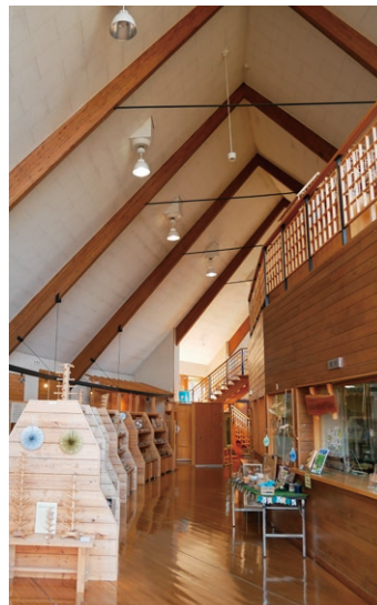
大断面集成材による吹抜け
