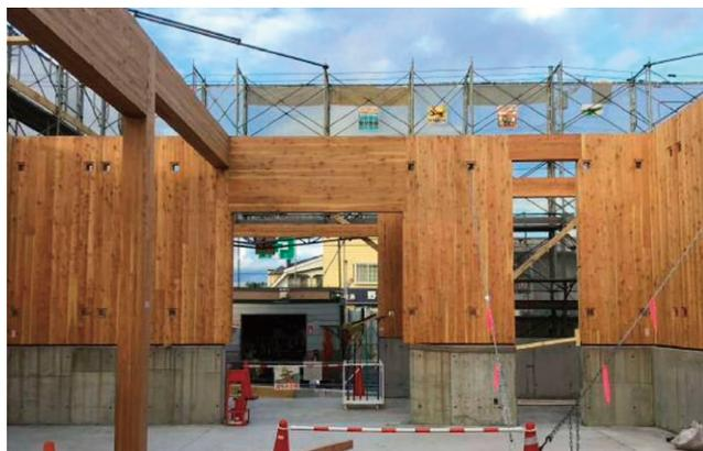
写真1 建方中のCLTパネル
