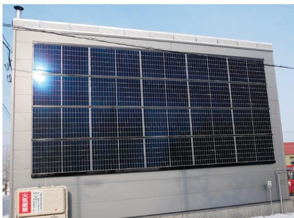
写真2 機械室の壁面に設置された太陽光発電パネル
