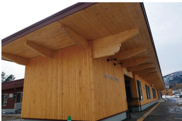
写真1 外装材(トドマツ)を保護する軒の張り出し梁がCLTの軒を支えている
