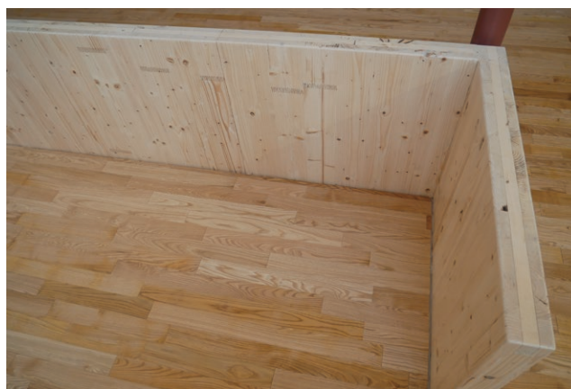
写真3 CLT製のパーティション
