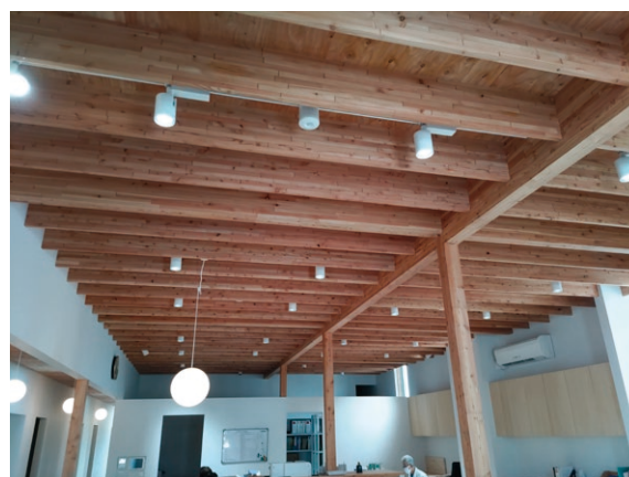
写真2 ワンルームの事務室（梁・柱はカラマツ集成材）
