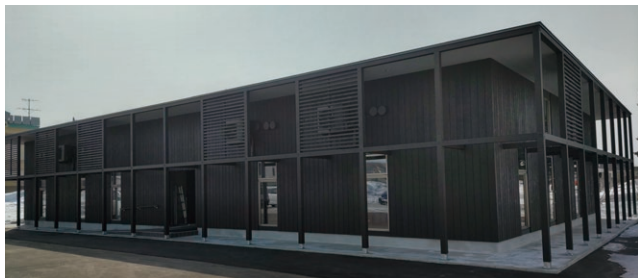
写真1 新事務所 正面（東面）
