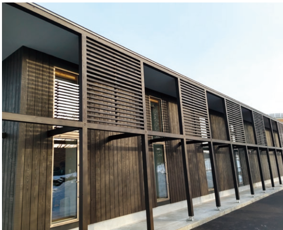
写真3 軒，木製ルーバー（西面）
