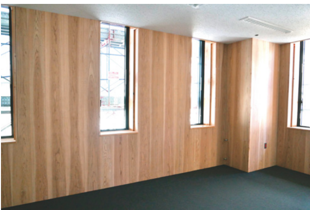
写真5 町長室のスギ板張り内装
