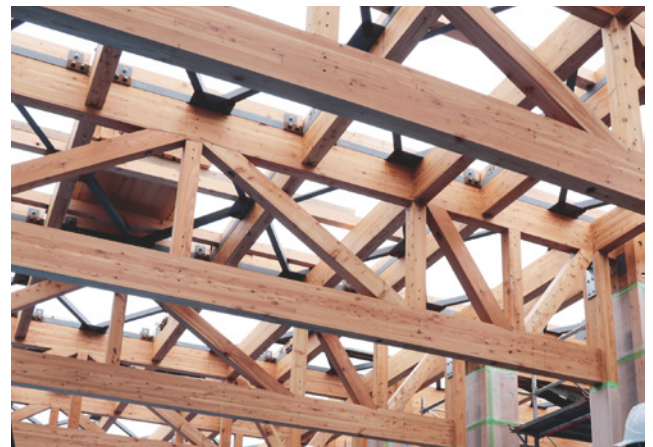
写真3 2階会議室のトラス構造
