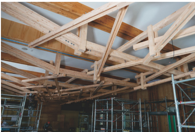
写真4 議場の張弦張り
