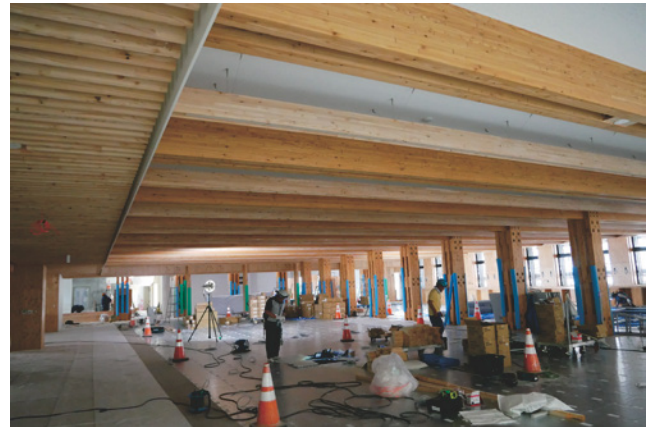
写真2 1階執務室のラーメン構造
