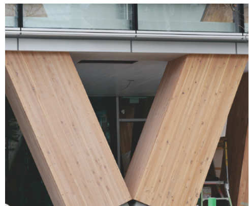
写真1 外部に露出している燃エンウッド斜め柱
